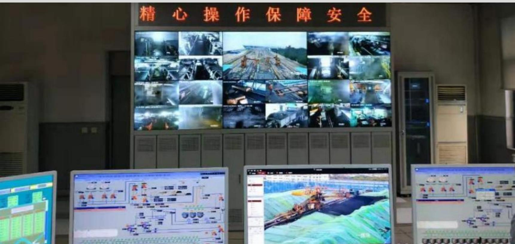
河北建投西柏坡电厂#2煤场、#3号煤场的3台堆取料机进行自动化作业改造，实现斗轮机无人值守功能：
